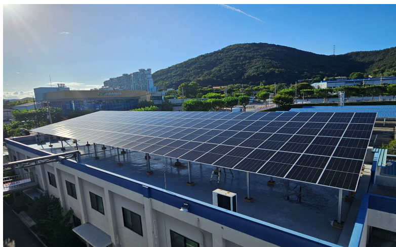
공장 옥상 태양광 설비 설치
